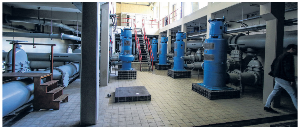
▲ In het pomphuis gaan de ingenieurs straks tussen de mansgrote pompen werken.
